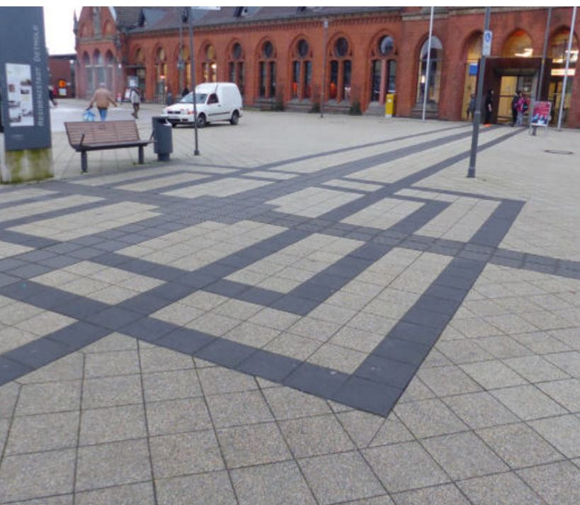
Betonsteine mit TiO 2 -Beimischung (Bahnhofvorplatz Detmold).
