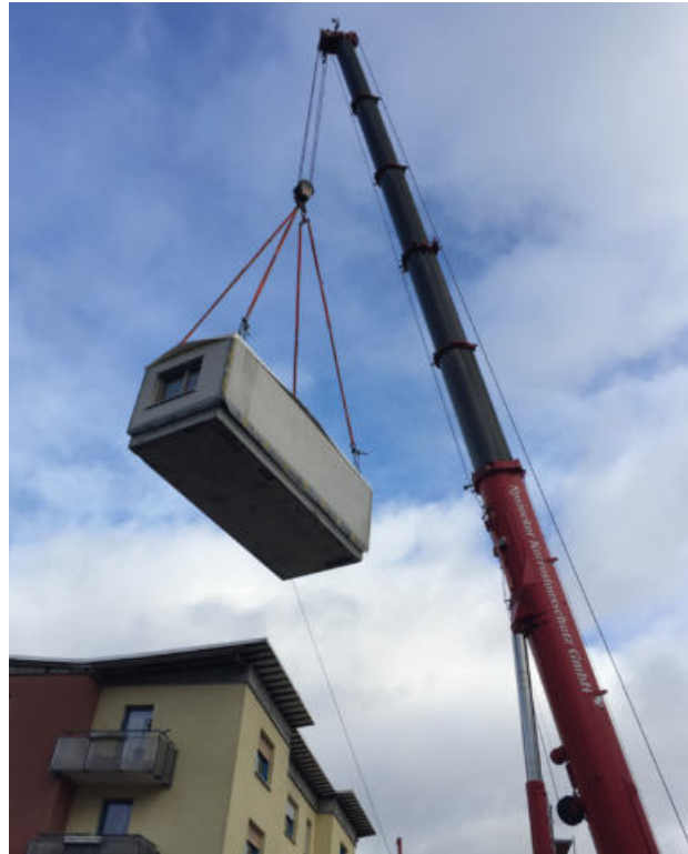
Die vorgefertigten Module wurden nach dem „Lego-Prinzip“ aufeinander gestapelt und miteinander verbunden.
