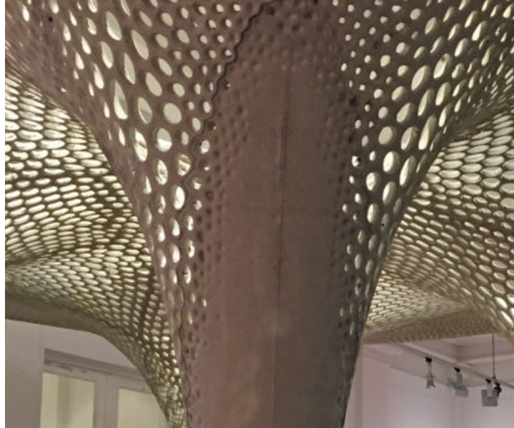
Der Einsatz von Gradientenbeton, die additive Fertigung und eine optimierte Formfindung reduzieren den Materialverbrauch.
