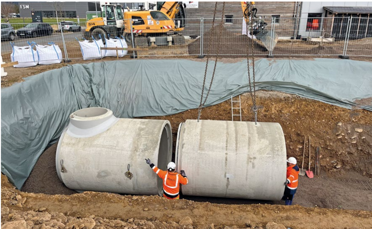
Montage der einzelnen Stahlbetonrohre.
