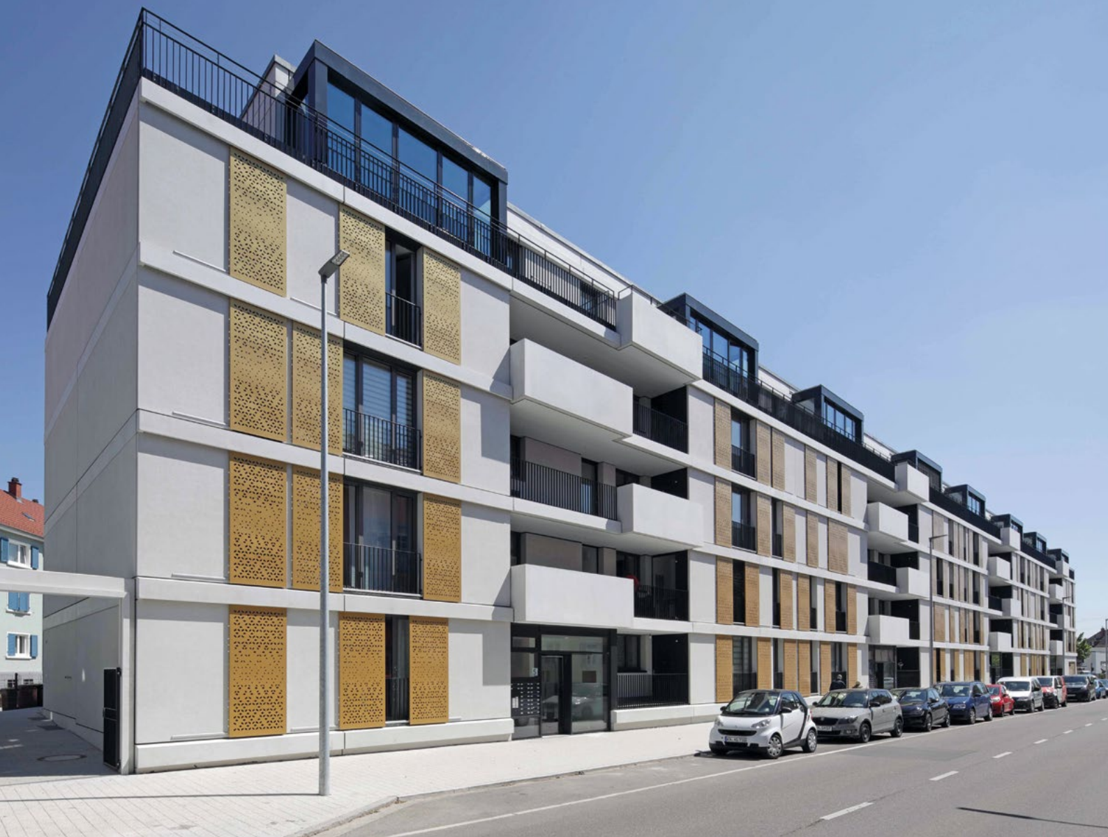
Praxedis-Gärten in Singen – nachhaltiger Wohnungsbau mit vorgefertigten Bauteilen.
