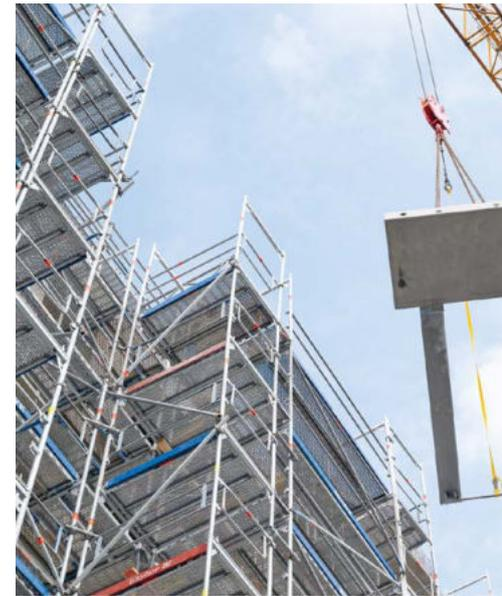
Im Betonfertigteilwerk wurden in den Balkon zwei bewehrte Stahleinbauteile mit jeweils einer Trägerplatte betoniert, die am Kopfende, zum Gebäude hin, mit dem Fertigteil abschließt.
