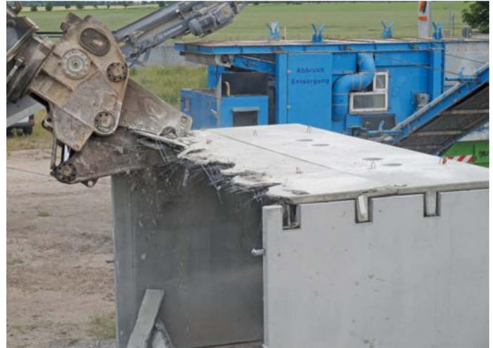
Maschineller Abbruch mit Abbruchzange (Abbruchverfahren Pressschneiden).
